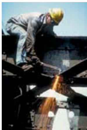
▲ El acetileno se quema a temperaturas elevadas, lo que hace a la reacción útil para cortar y soldar hierro.
