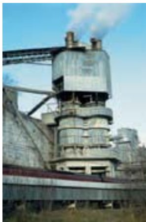
▲ La fabricación del cemento comienza con la descomposición térmica de la piedra caliza, CaCO 3 , en grandes hornos.
